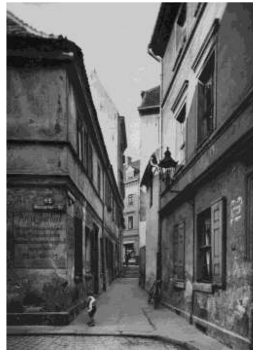
Abb. 72) Blick in das Nadelöhr Weißgerbersteg Richtung Berliner Straße (Fotobestand Hochbauamt, Foto Nr. 5964, vom 8.3.1930)
