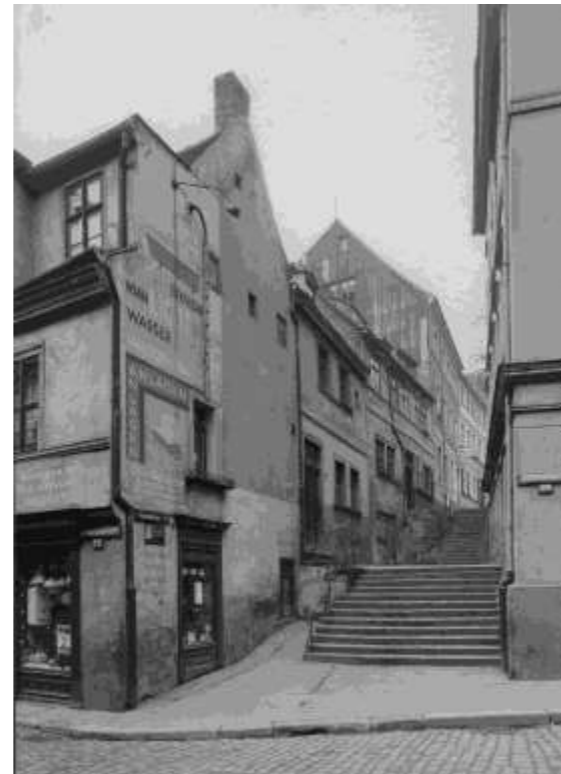
Abb. 3) Blick in den Trommelsberg (Fotobestand Hochbauamt, Nr. 14347, vom 02.02.1938)
