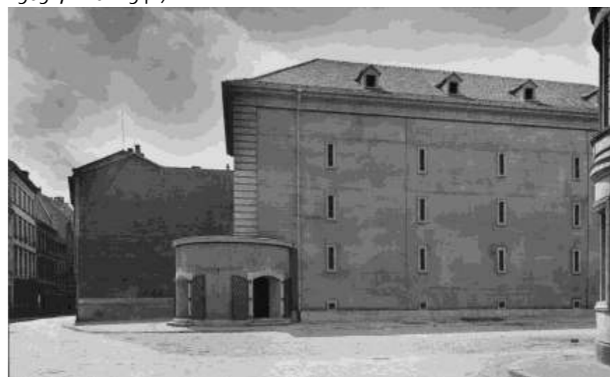
Abb. 19) Bunker Fürstenstraße 23 (Fotobestand Hochbauamt, Foto Nr. 21312, 24.07.1942)
