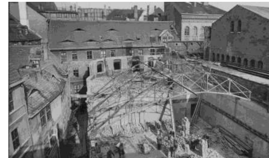
Abb. 85) Abbruch des Friedrichsbades, links die Weißgerberstraße, geradeaus der Weißgerbersteg mit dem Hintergebäuden der Fürstenstraße 23a (Fotobestand Hochbauamt, Foto Nr. 10500, vom 28.7.1933)
