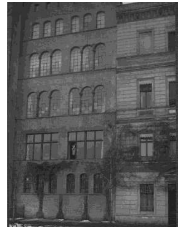
Abb. 77) Tabakfabrik Nathusius Am alten Brücktor 10, Ansicht des Fabrikgebäudes zum Schleinufer (Fotobestand Tiefbauamt, Foto Nr. TB3 363, vom 19.12.1927)
