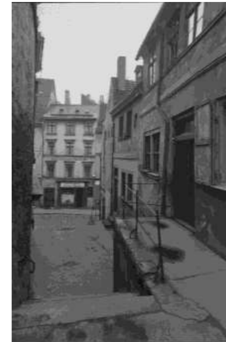
Abb. 66) Trommelsberg, Blick von Westen nach Osten (Fotobestand Hochbauamt, Foto Nr. 14349, vom 2.2.1938)
