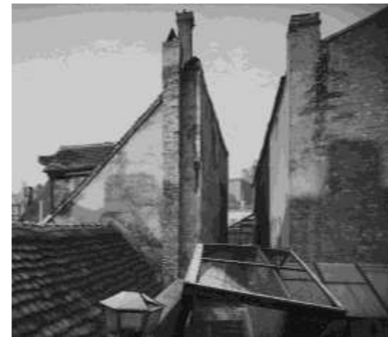
Abb. 17) Dachlandschaft in der Fürstenstraße (Fotobestand Hochbauamt, Foto Nr. 10040, vom 7.12.1932)
