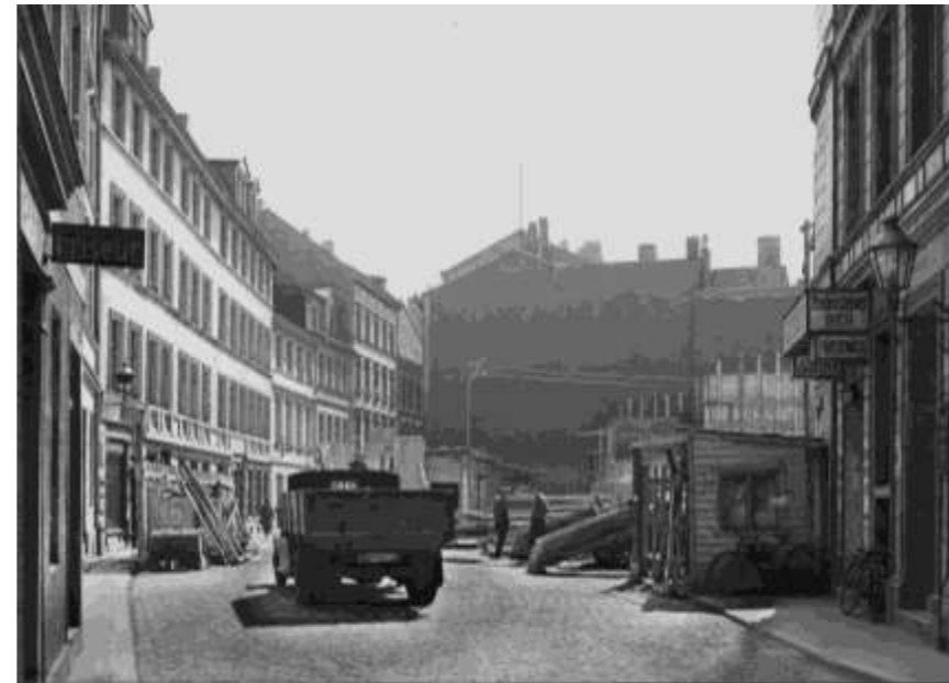
Abb. 41) Fürstenstraße nach Süden mit der Baustelle für den Hochbunker (Fotobestand Hochbauamt, Foto Nr. 20041, vom 2.4.1941)
