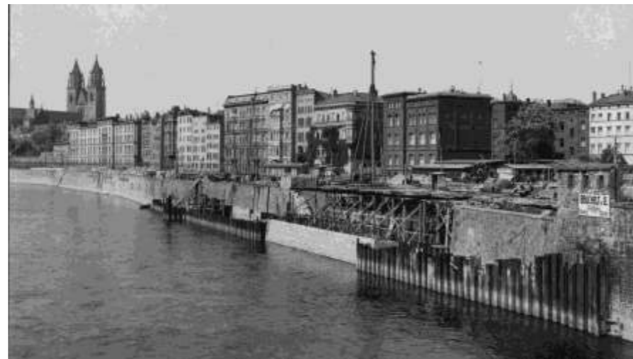
Abb. 44) Fürstenufer Richtung Süden mit der Baustelle rechts für den Strombrückenneubau (Fotobestand Hochbauamt, Foto Nr. 16373, vom 10.6.1939)
