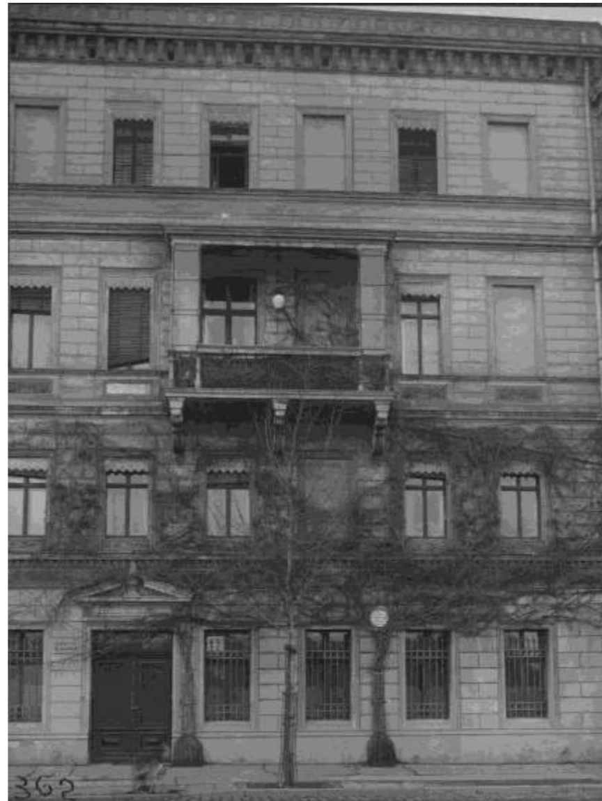
Abb. 76) Tabakfabrik Nathusius Am alten Brücktor 10, Ansicht zum Schleinufer (Fotobestand Tiefbauamt, Foto Nr. TB3 362, vom 19.12.1927)
