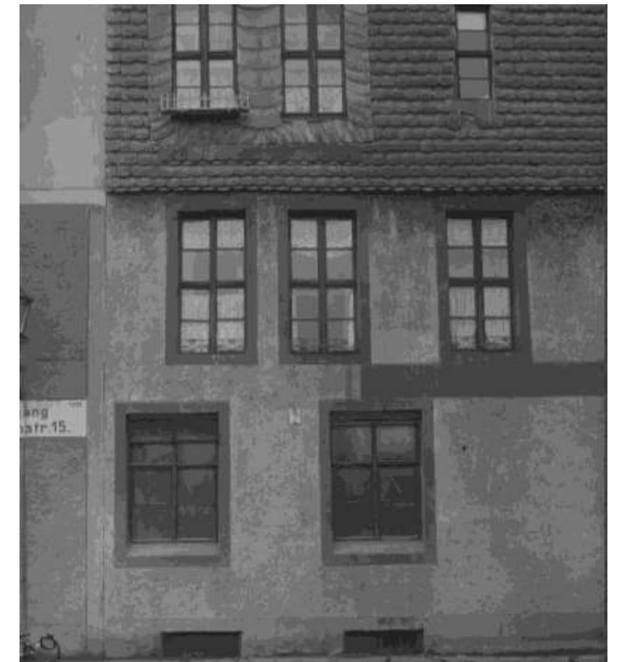
Abb. 45) Gebäude am Fürstenufer, das postalisch zur Fürstenstraße 16 gehörte, hier ist die dicke Wand der Stadtmauer in der Fassade verbaut (Fotobestand Tiefbauamt, Nr. 369, vom 16.1.1928)
