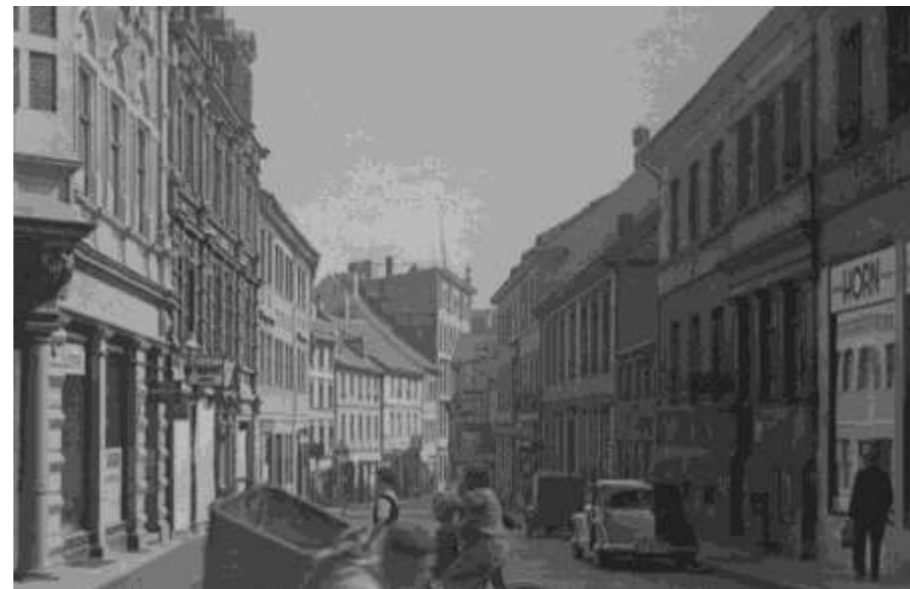
Abb. 61) Blick in die Johannissfahrtstraße Richtung der Kreuzung Am Alten Brücktor, hinten links das viereinhalbgeschossige Geschäftshaus des Möbelhändlers Paul Knüppelholz Am alten Brücktor 11 (Fotobestand Hochbauamt, Foto Nr. 31466, 1930er Jahre)
