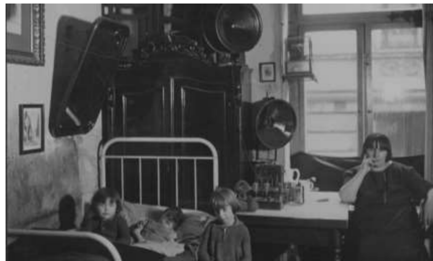
Abb. 16) Notwohnung Fürstenstraße 23 (Fotobestand Hochbauamt, Foto Nr. 10047, 1932)
