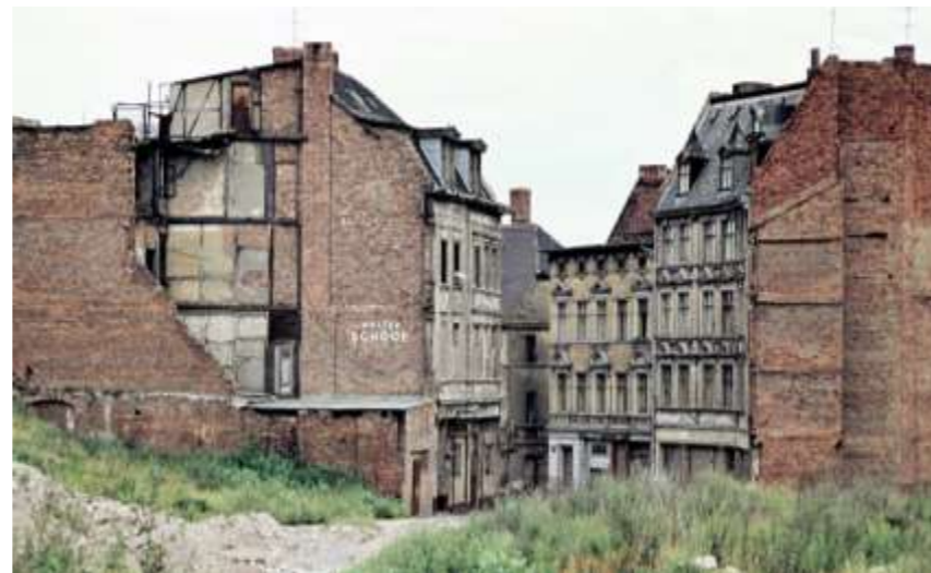
Abb. 37) Die Berliner Straße vor dem Abriss der letzten Gebäude, zu sehen sind die Hausnummern 25/26 (links), 16/17, 18a, 18b (rechts, von rechts nach links) im Juli 1963, Foto Hermann Brösel (Brösel Familienarchiv)
