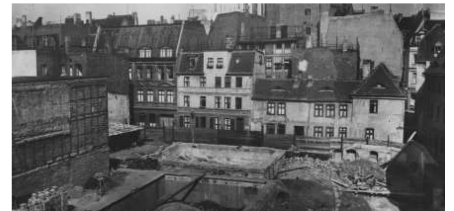
Abb. 70) Blick über Abbrucharbeiten am Friedrichsbad auf die Gebäude an der Weißgerberstraße 6c bis d und Weißgerbersteg 2, um 1933 (Fotobestand Karton, Nr. K I/49 (in Broschüre als Nr. K I/19 bezeichnet))
