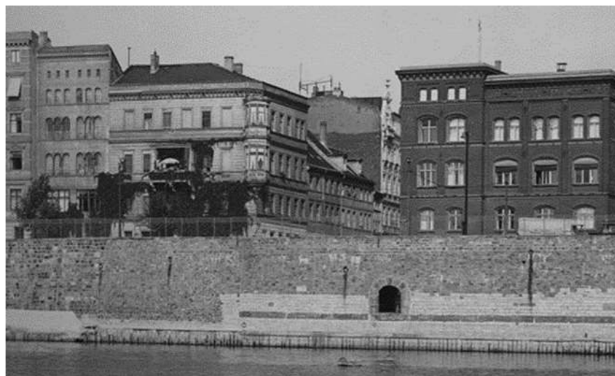
Abb. 32) Blick vom Schleifufer in die Straße Am alten Brücktor, links die Zigarrenfabrik Lindau und Winterfeld mit der Hausnummer 10, rechts das 1885 erbaute Verwaltungsgebäude des Eisenbahnfiskus mit der Adresse Knochenhaueruferstraße 1 (Fotobestand Hochbauamt, Foto Nr. 11199, vom 31.7.1934)
