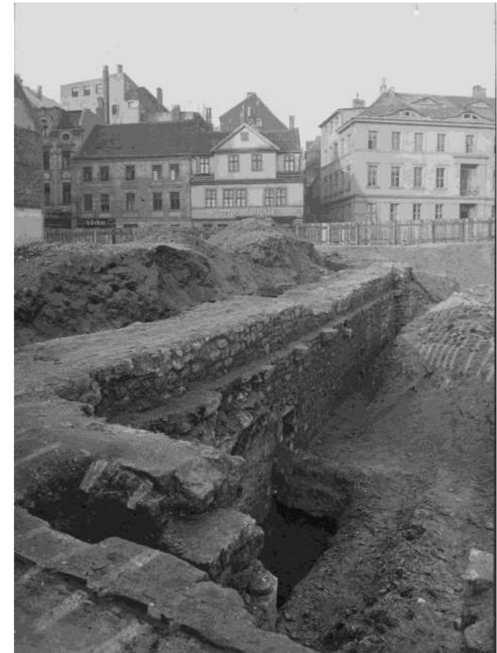
Abb. 7) Auf dem Abbruchgelände zum Brückenneubau über die Stromelbe kamen mittelalterliche Mauerreste zutage, hinter dem Bauzaun die Johannisfahrtstraße mit der hier abzweigenden steilen Gasse Trommelsberg (Fotobestand Hochbauamt, Nr. 18626, vom 30.11.1940)
